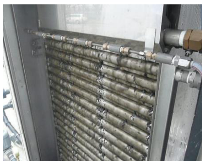
「汚泥」流下状況
