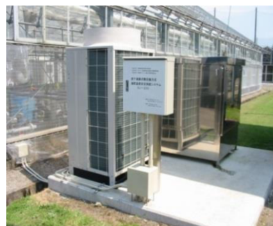
奥が熱交換器、手前はチラー
