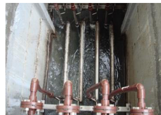
熱交換器設置状況
